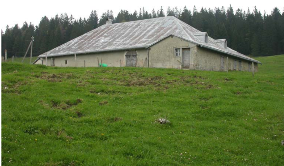
Le chalet du Milieu vu d'en dessous
